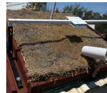
Figure 20 – Test de gazon en toiture
