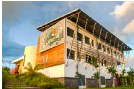
Figure 9 – ENERPOS : Premier bâtiment tertiaire à Énergie Positive dédié à l'enseignement construit sous les tropiques en 2008 11
