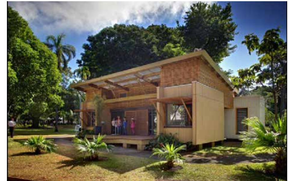
Figure 41- Exemple de maison individuelle : Case Démétée à Beauséjour
